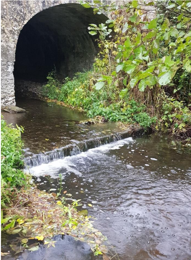
Radier du pont avant travaux
